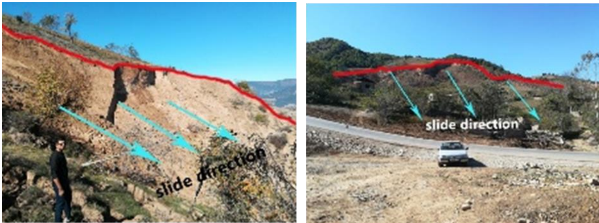
شکل ۲: تعدادی از زمین لغزش‌های شناسایی شده در روستای صفی‌آباد
