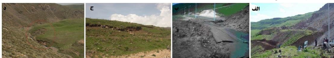
شکل ۸: نمونه‌هایی از زمین‌لغزش‌ها رخ داده در سطح شهرستان نیر، الف و ب: جاده نیر- سراب (گردنه صائین)، ج: اطراف روستای گوگرچین د: اطراف روستای لای
