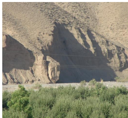
شکل ۲۵: زمین لغزش با سطح مقطع قوسی در غرب حوضه
