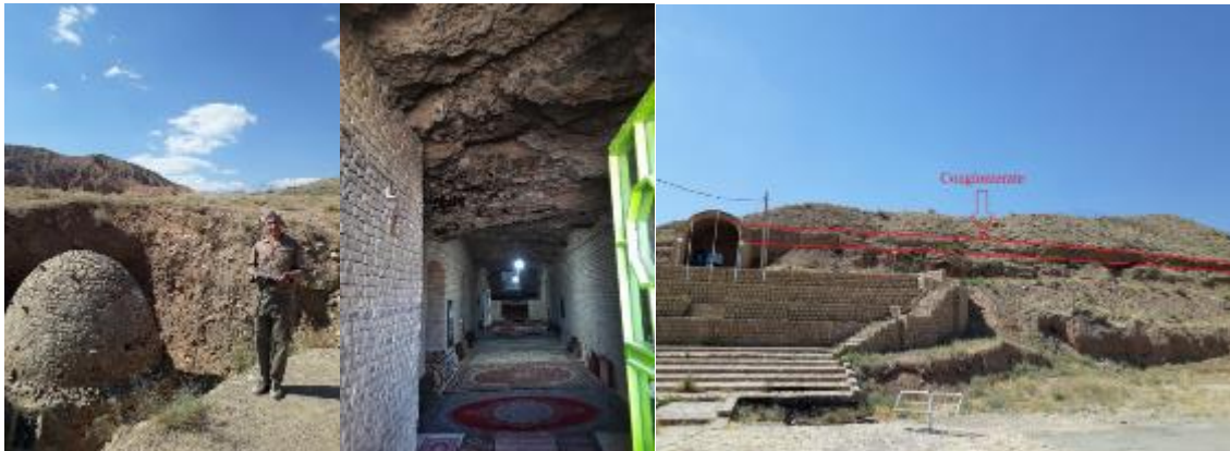
شکل ۲۳: کنگولمرای نئوژن منطبق بر سقف (سمت راست)، نمای دالان (وسط) و نمای خارجی و گنبد بارگاه غار دستکند با با قدرت (سمت چپ)
