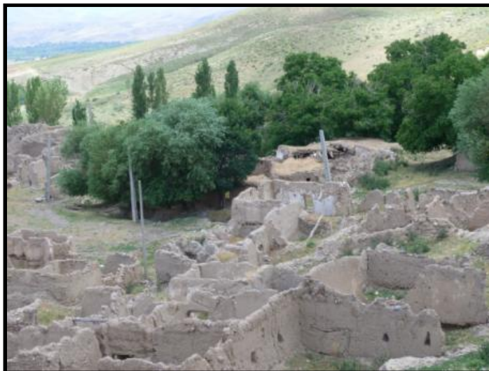
شکل ۶: نمایی از روستای سویین که بر اثر خسارات ناشی از وقوع زمین‌لغزش سال ۱۳۸۴ متروکه شده است
