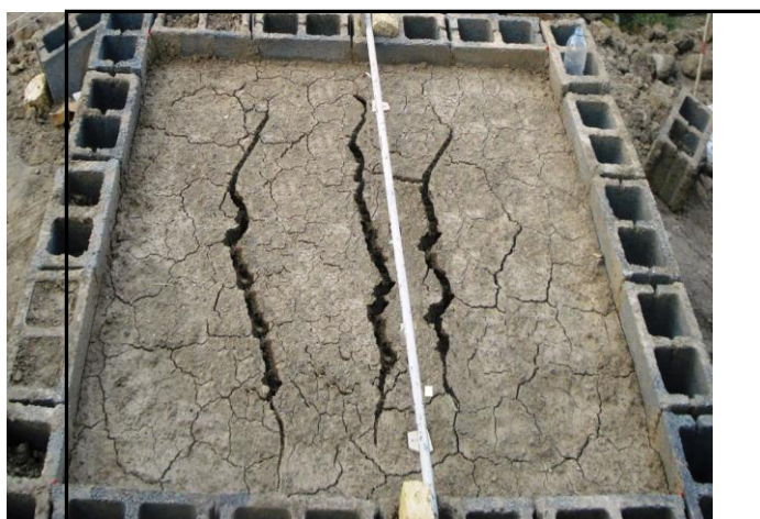
شکل شماره ۸: ظهور درز و شکافهای عمیق در سطح مدل دینامیک
