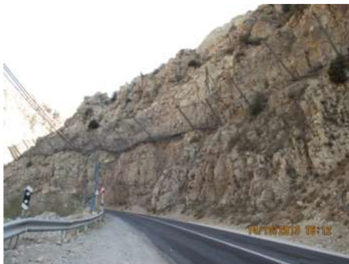
شکل ۳: سنگ‌های شکسته بر روی دامنه‌های فعال و سازه‌های محافظتی ژئوتکنستالی (مکان جاده شمشک به تهران در محدوده حوضه آبریز).
