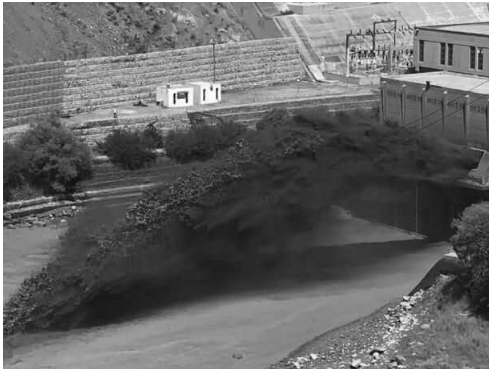
شکل ۷: وجود رسوبات معلق فراوان در پشت دیواره سد لتیان که موجب گل‌آلود شدن آب خروجی از سد می شود
