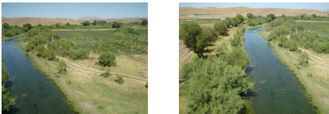
شکل ۷: تنگ‌شدگی مجرای رودخانه قره‌سو در اثر کشت محصولات کشاورزی در محدوده بستر و حریم رودخانه قره‌سو
