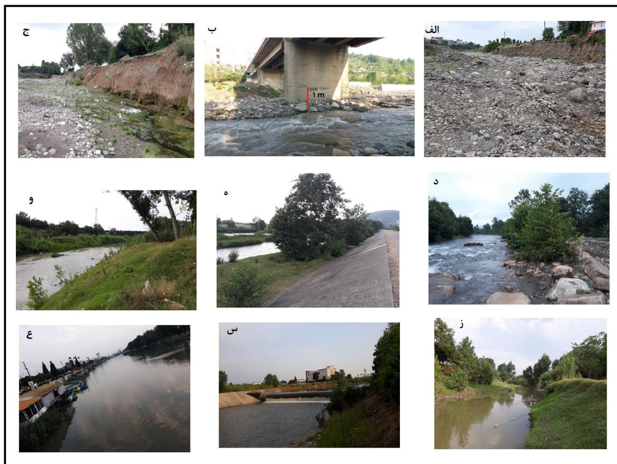
شکل ۳: الف) بستر و کرانه آبرفتی بازه ۱، ب) فروسایی بستر در پایه پل در بازه ۱، ج) پسروری کرانه آبرفتی در بازه ۲، د) بستر بازه ۳، ه) دیوار حفاظتی در بازه ۴، و) بخشی از بازه ۵، ز) کرانه و بستر بازه ۶، س) وجود سد لاستیکی در بازه ۷، ع) تجاوز به حریم رود در بازه ۸.
