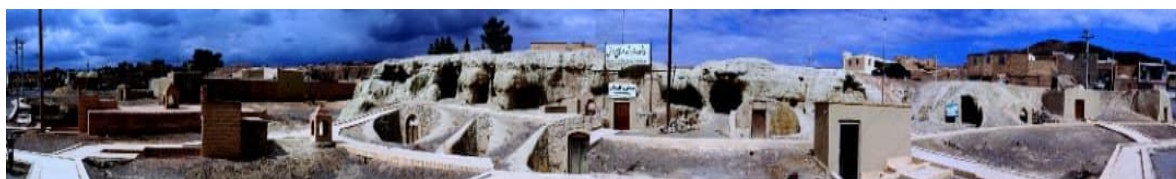
شکل ۱۰: کارگاه‌های عبابافی محمدیه، تراس یا یادگانه رسی دریاچه‌ای، کارگاه‌ها به صورت دستکند در تراس کنده شده‌اند عکس از باباجمالی، ۱۳۹۶
