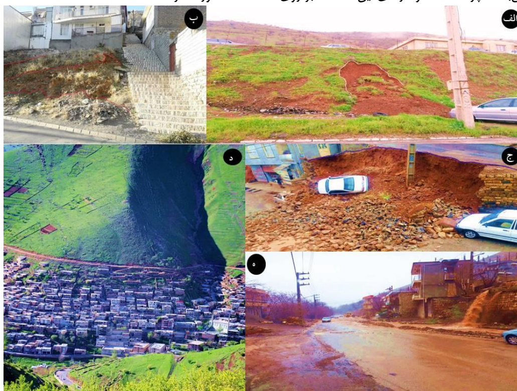
شکل ۵. الف) زمین لغزش‌های کوچک در نتیجه بارش سنگین و زیربری جاده ب) تأثیرات افزایش وزن سازه‌ها بر ناپایداری دامنه‌ها در بخش شمال غربی پاوه ج) فروریختن دیواره کنار جاده‌ها در نتیجه تردد کامیون‌های سنگین و ایجاد خسارت به منابع انسانی د) دره یالی در محله مسجد جامع و تخریب آسفالت و سنگفرش معابر ه) افزایش رواناب‌های سطحی در بخش شمال غربی پاوه
