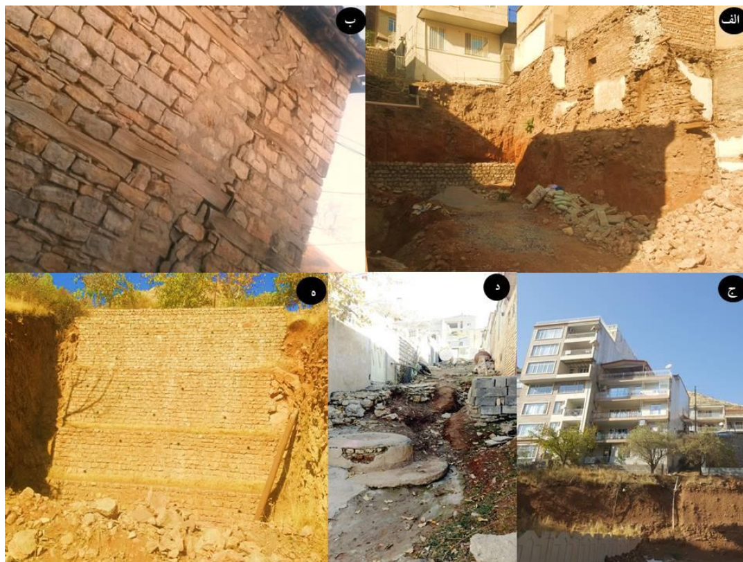
شکل ۴. الف) خاک‌برداری‌های غیراستاندارد در بافت قدیمی (ب) ترک‌خوردگی دیوارهای خانه‌های قدیمی (ج) بلندمرتبه‌سازی در شیب‌های غیراستاندارد (د) ایجاد آب‌کنند در محلات بالادست دره با سم (ه) ایجاد دیوار حائل ۸ متری و افزایش هزینه ساخت‌وساز
