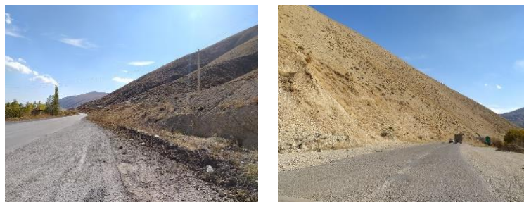
شکل ۱۸: تصویر سمت راست: جاده بهمن گیر کلور به شمال، سمت چپ: جاده بهمن گیر اسکستان
