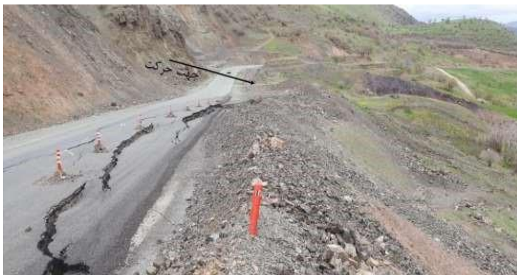
شکل ۲۱- نمونه ای از زمین لغزش حاصل گسل اصلی زاگرس در مسیر جاده مریوان به سروآباد
