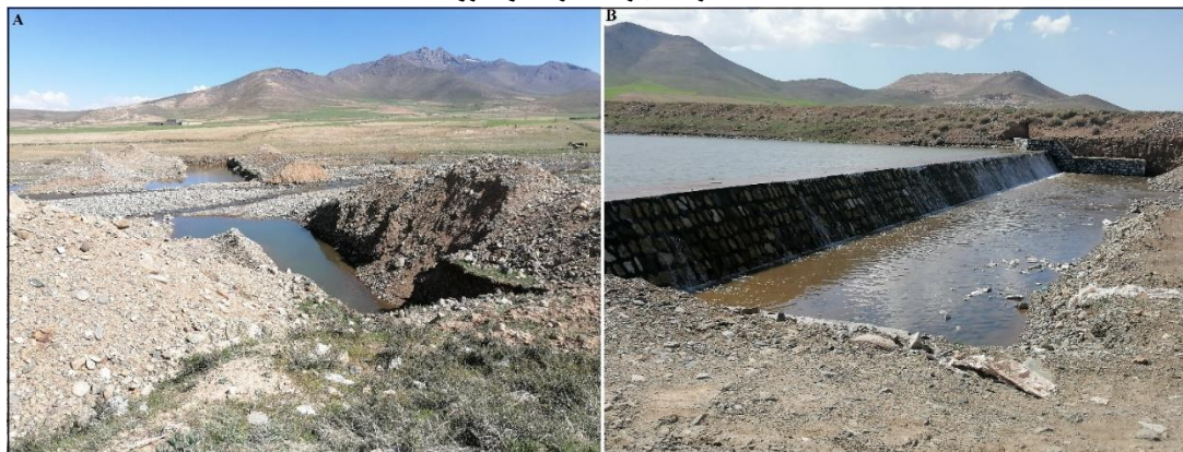
شکل ۱۰. احداث پروژه آبخیزداری سیل بند، برداشت شن و ماسه و ایجاد خندق در سطح بستر رودخانه
